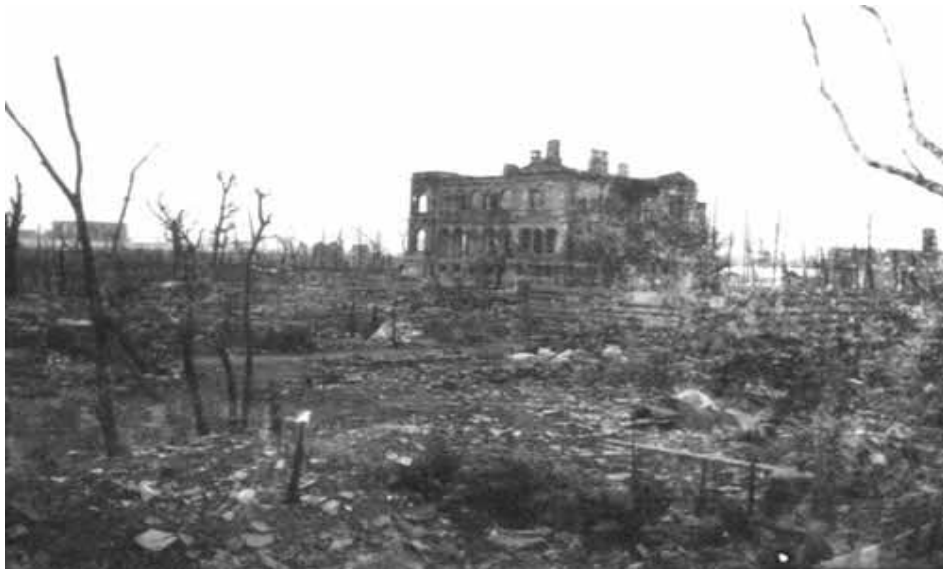
Blick auf den verwüsteten Yasuda-Garten und das zerstörte ehemalige Anwesen der Industriellenfamilie Yasuda in Ryōgoku nach dem Großen Kantō-Erdbeben im September 1923. Quelle: National Museum of Nature and Science, Tōkyō.
